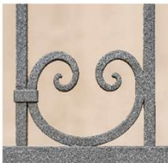
圖21、熟鐵即加工過的鐵，含碳量小於0.02%的鐵碳合金，常見於歷史建築、欄杆、藝術鐵件 圖片來源：Microsoft, Copilot
